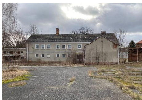
Abb. 13: Zweigeschossiges Gebäude am Dorfanger, Rückseite
