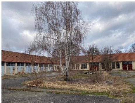
Abb. 9: Hofbereich, westliche und südliche Seite
