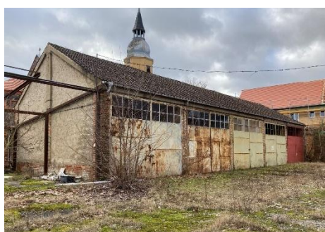
Abb. 15: Wirtschaftsgebäude am Dorfanger, Rückseite
