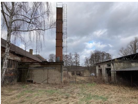
Abb. 20: Bereich östlich Hofanlage
