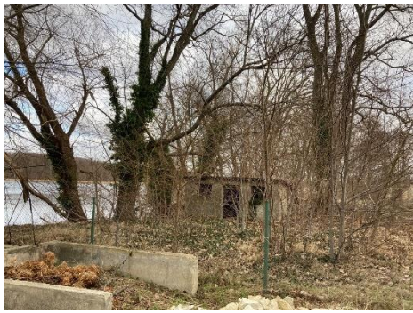
Abb. 22: Ruinöse Bebauung nördlicher Uferbereich
