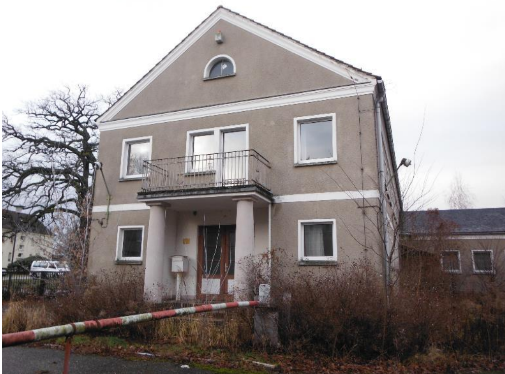
Abb. 7: nicht mehr genutztes Wohngebäude; derzeit noch in einem guten Zustand
