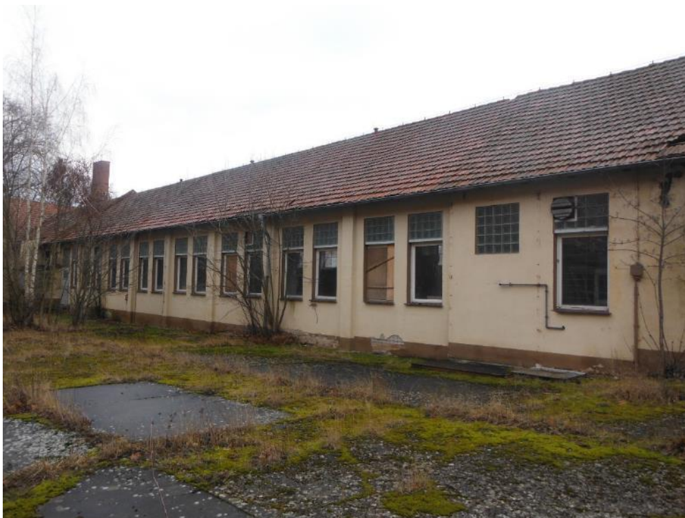
Abb. 15: zentrales Gebäude mit Mehlschwalbennester an der Dachkante; hier Gebäuderückseite
