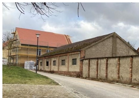
Abb. 14: Wirtschaftsgebäude am Dorfanger
