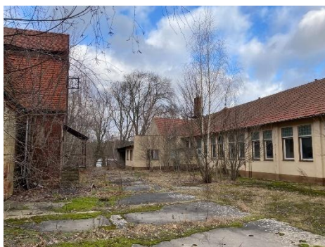
Abb. 21: Bereich zwischen Hofanlage und Stanze
