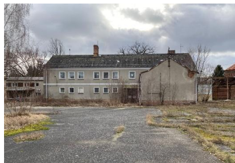
Abb. 13: Zweigeschossiges Gebäude am Dorfanger, Rückseite
