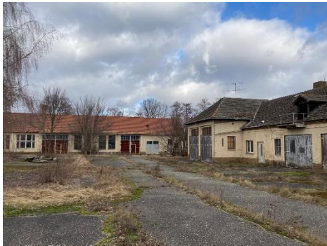
Abb. 8: Hofbereich, nördliche und westliche Seite
