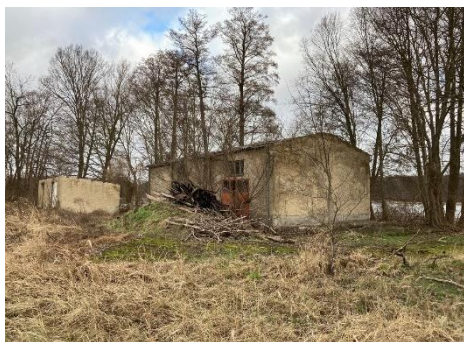
Abb. 24: Ruinöse Bebauung nordöstlicher Uferbereich
