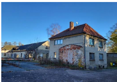
Abb. 17: Kleineres Gebäude südöstlich Hofanlage
