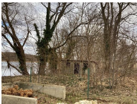
Abb. 22: Ruinöse Bebauung nördlicher Uferbereich
