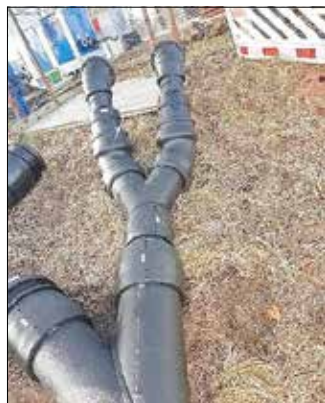
Neuverlegte Druckleitungen
