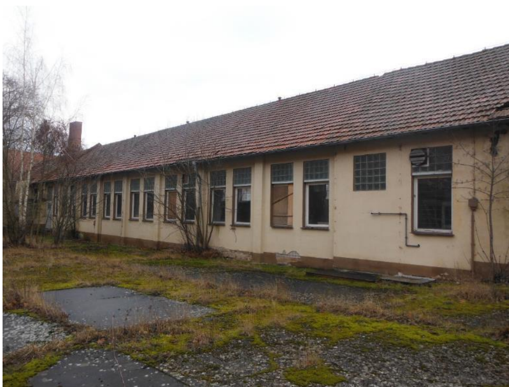
Abb. 15: zentrales Gebäude mit Mehlschwalbennester an der Dachkante; hier Gebäuderückseite
