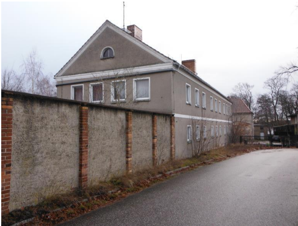
Abb. 6: Blick von der Schlosstraße auf die südlichen Gebäude des KFL-Geländes
